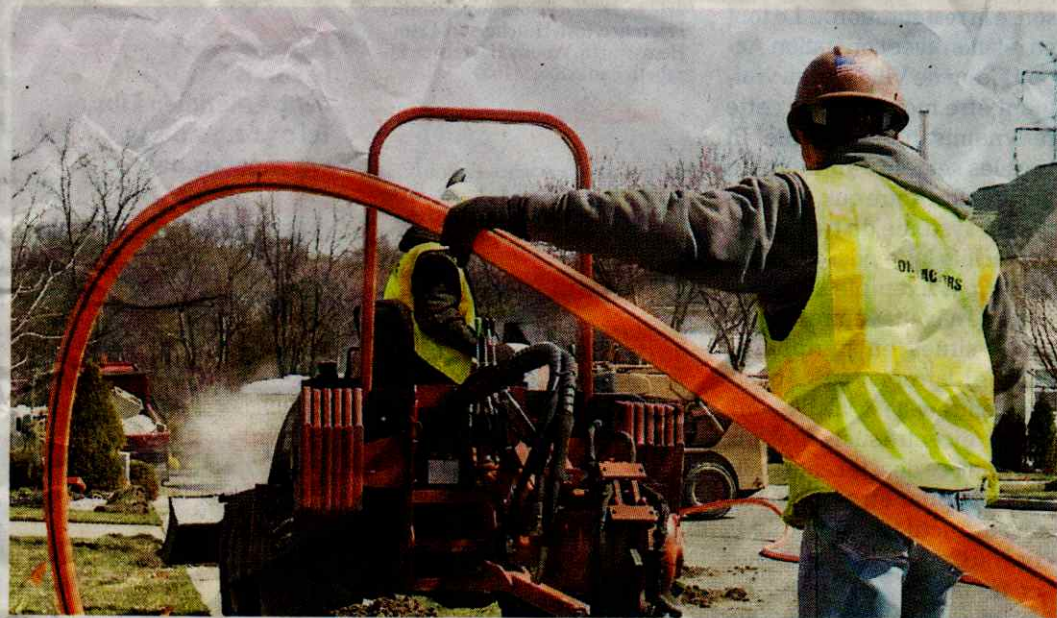
Travaux d'installation de la fibre.
