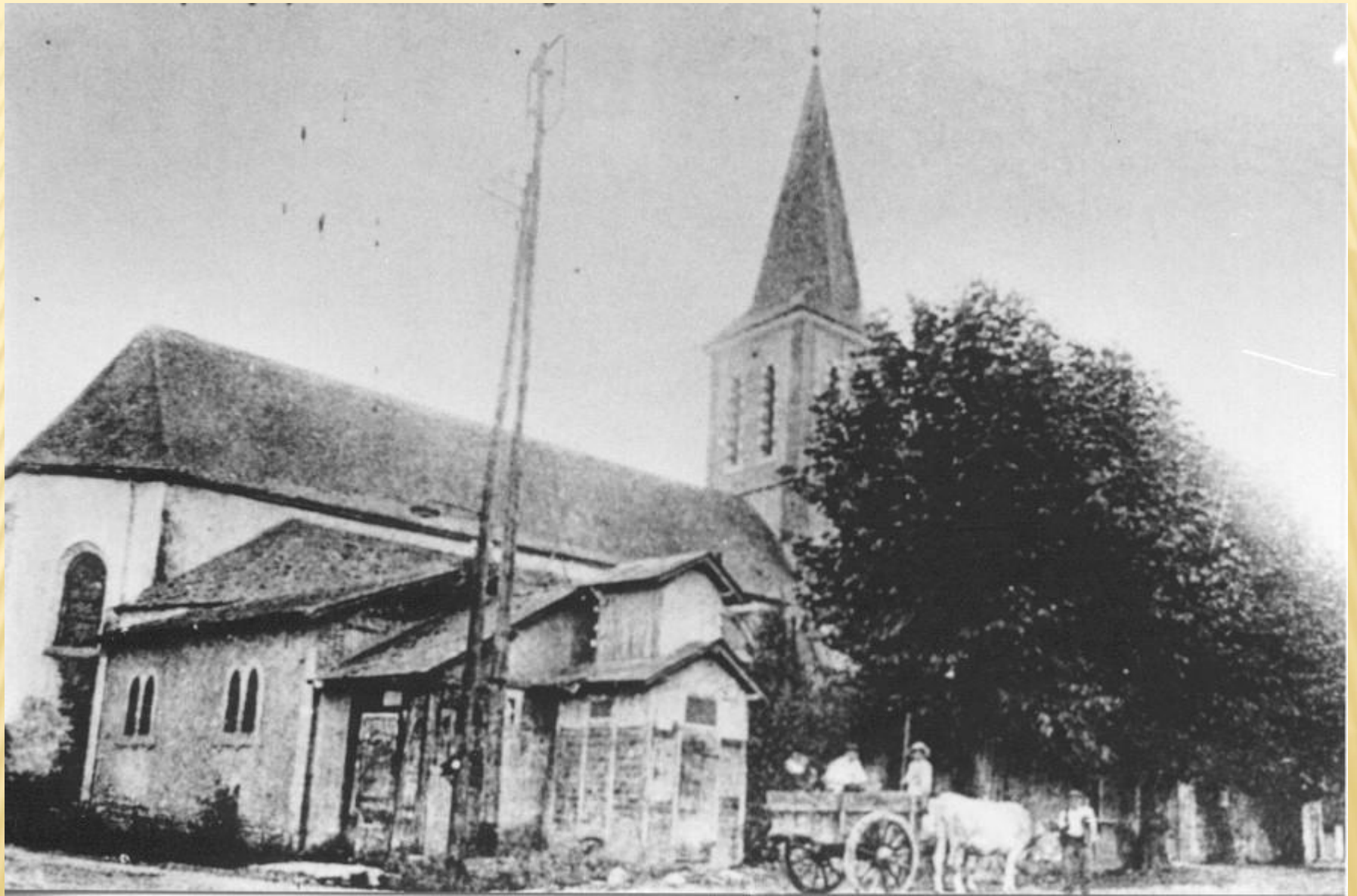
L'église avant la démolition de la sacristie nord. Source : mairie de Soues.
