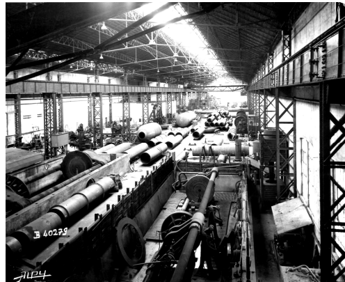
Atelier de soudure des canalisations d'eau
