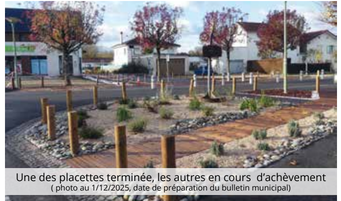
Les agents du service espaces verts ont réalisé l'aménagement des placettes.
