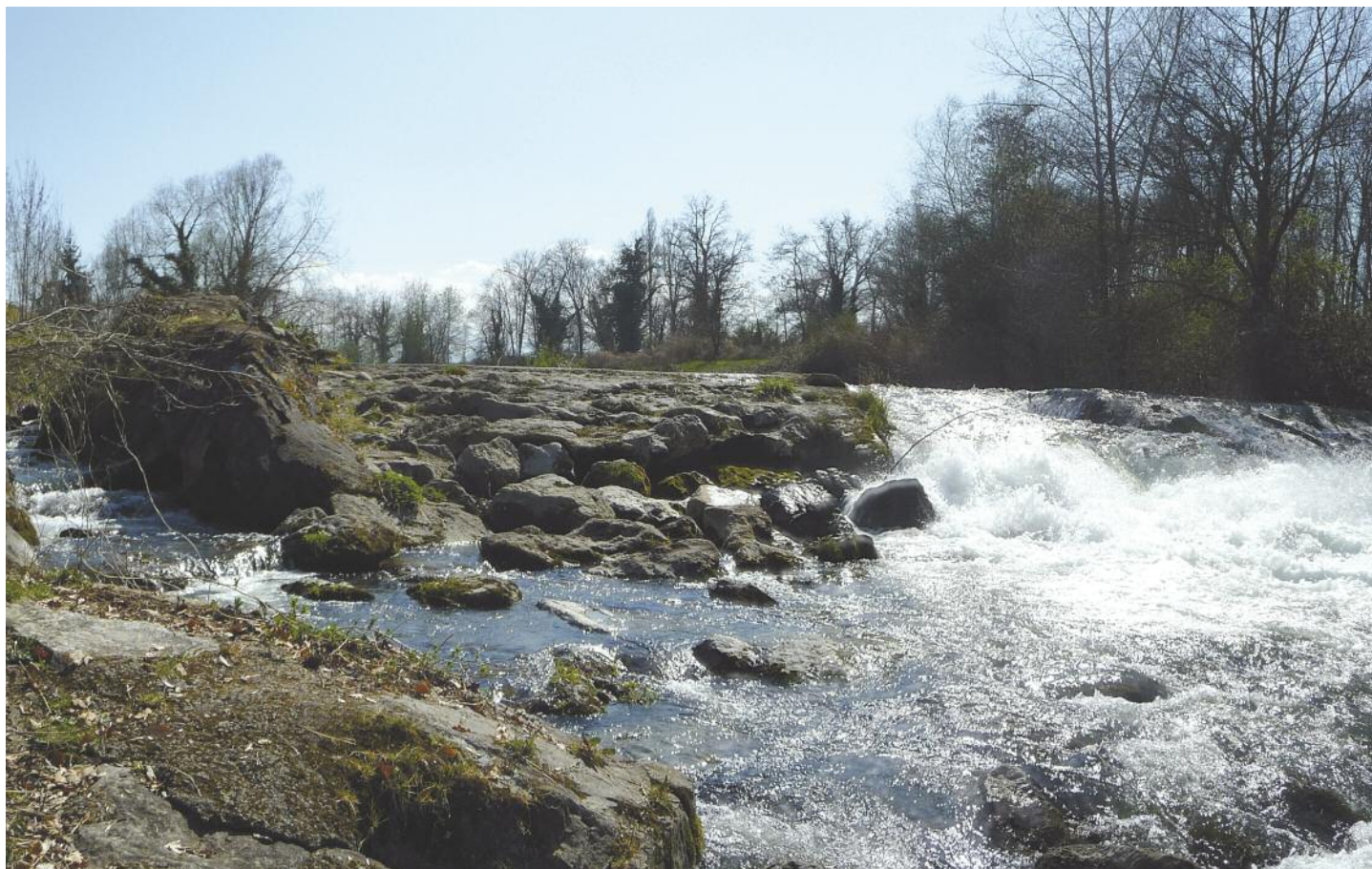
Vue aval du seuil situé à hauteur du lac de Soues et de sa rivière de contournement (à gauche)
