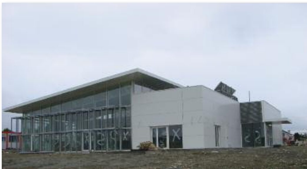
Vue du futur restaurant inter-entreprises en travaux
