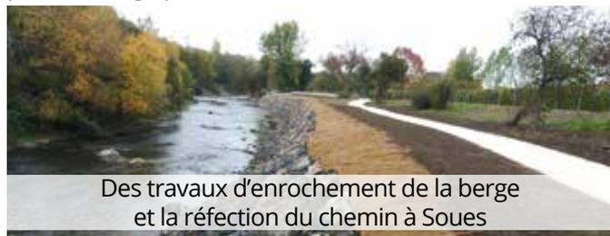
Des travaux d'enrochement de la berge et la réfection du chemin à Soues
