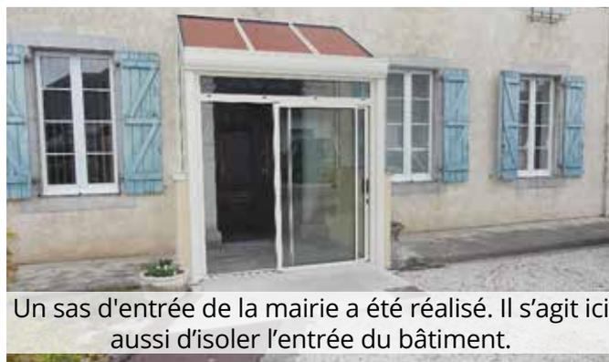
Un sas d'entrée de la mairie a été réalisé. Il s'agit ici aussi d'isoler l'entrée du bâtiment.
