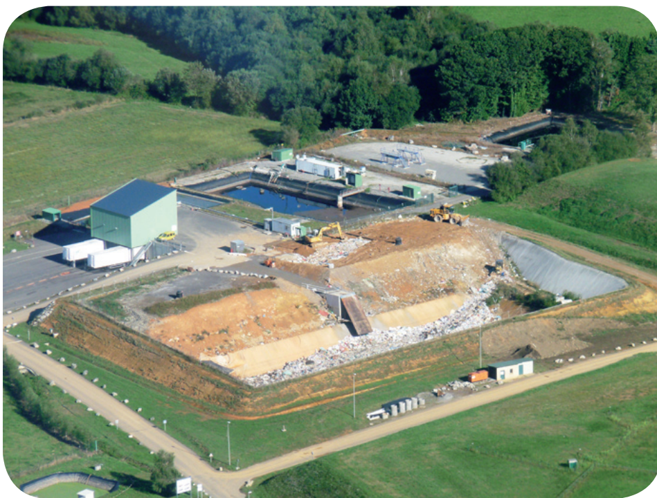
Casier de stockage et Quai de Transfert de CAPVERN
